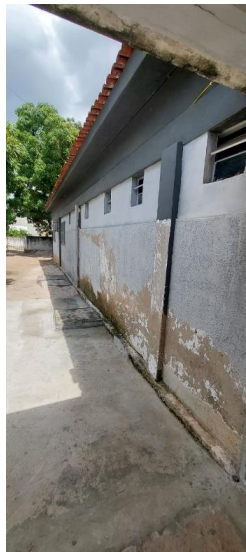
Imagem 4 - Paredes com umidade
